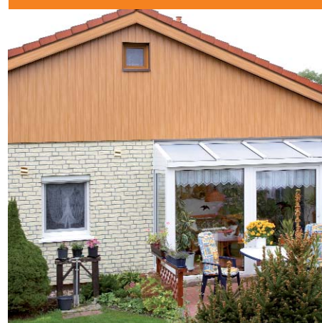
Nach der Renovierung mit vinyPlus DRP
