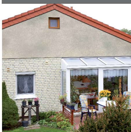
Vor der Renovierung mit vinyPlus DRP
